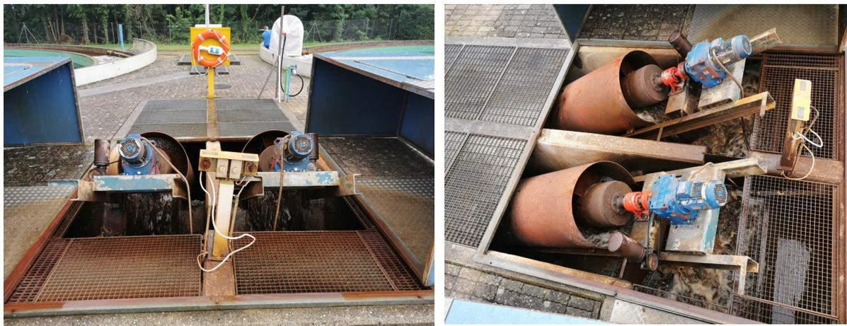
Il s'agit de vis d'Archimède permettant la recirculation des boues dans les bassins de la biologie qui assure la dégradation de la pollution dans le cycle de l'eau.
